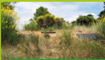
La vieille cuve de stockage.
